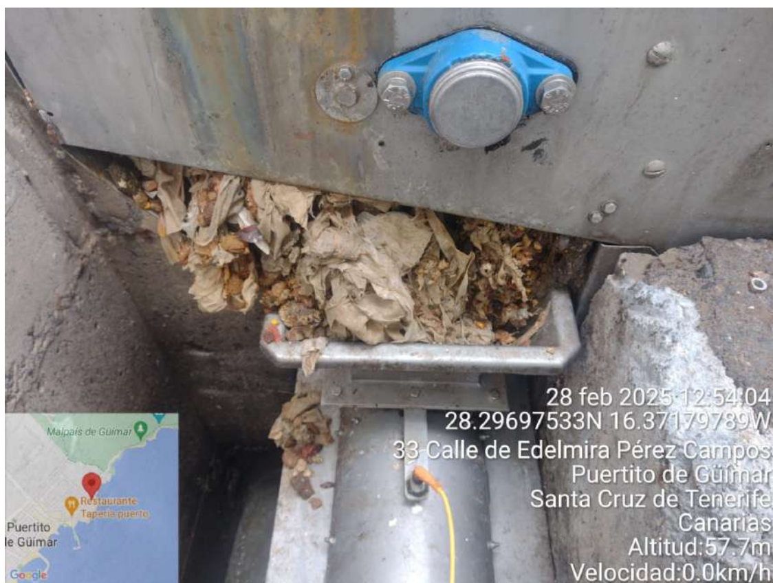
Aqualia realiza labores de limpieza y mantenimiento de la red de saneamiento de forma continua durante todo el año
