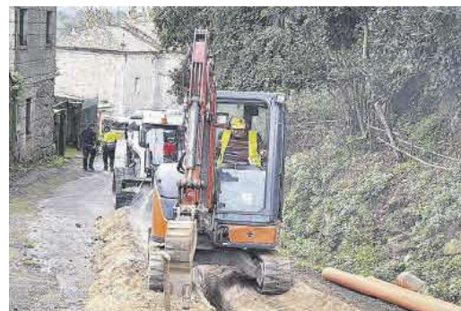
Trabajos en camiño das Angustias. | D.P.
